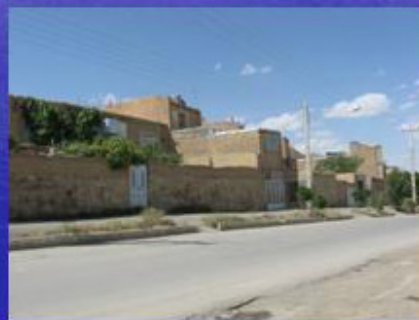
ساختمان های آجری- تیر آهنی
